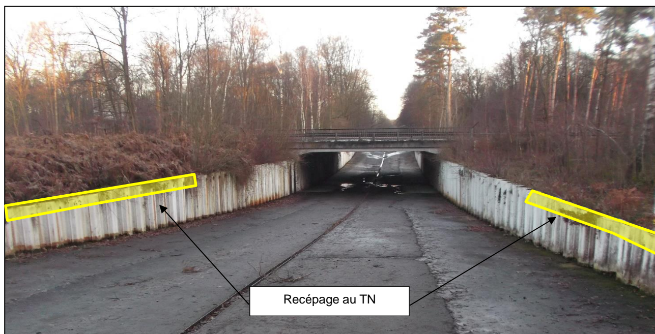
Figure 6 : Schéma de principe de recépage des palplanches
